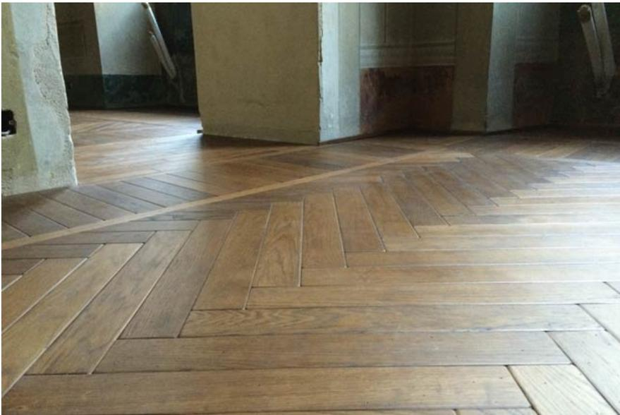
**Un parquet multistrato dello spessore di 1 cm**, per garantire maggiore efficienza termica all'ambiente e il corretto funzionamento dell'impianto radiante evitando così la deformazione del materiale, e di cui **ogni singolo listello è stato bottato a mano** per ottenere un effetto stonato che contribuisce a impreziosire ulteriormente l'appartamento.
