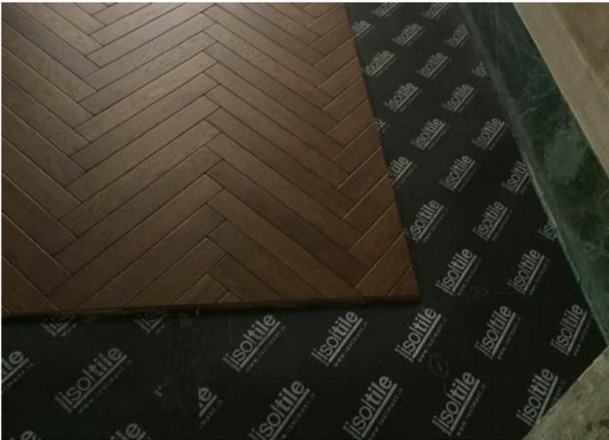
Per questo è stata posta particolare attenzione alla progettazione degli impianti di riscaldamento e idrico, per limitare al massimo eventuali segni lasciati dalla loro realizzazione, procedendo perciò all'installazione di sistemi radianti a pavimento a basso spessore all'ingresso, nei due saloni e in uno dei due bagni mentre nelle altre stanze sono stati installati dei radiatori per mantenere intatta e inalterata l'originaria pavimentazione in cotto.
