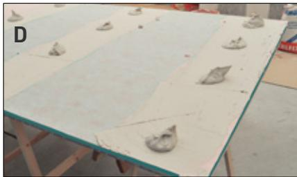
**FISSAGGIO DELLE LASTRE CON COLLA A BASE DI GESSO**
