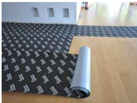
Il materassino **IsoTile AD** è stato utilizzato da base per la posa, con colla tradizionale, della ceramica. Questo innovativo prodotto di Isolmant è un **manto acustico desolidificante e armante per rivestimenti, ideato per la posa delle pavimentazioni in ceramica o in parquet.** È composto da polipropilene.
