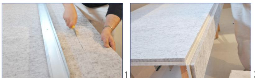
A riguardo, qualora a seguito delle dimensioni geometriche della parete, risultasse necessario tagliare le lastre, il taglio dovrà essere eseguito incidendo prima lo strato di isolante e successivamente il cartone per poi procedere con un colpo secco alla rottura della lastra stessa (fig.1 e 2).
