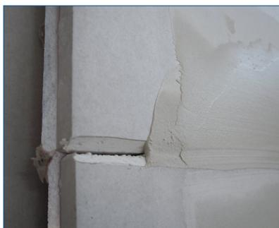
1. Lo stucco dovrà essere distribuito con una spatola d'acciaio sui giunti delle lastre, avendo cura di riempire le giunture abbondantemente in modo da raggiungere il livello della superficie delle lastre e preparare in tal modo il supporto idoneo per la posa del coprigiunto (fig. 9).
