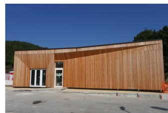
Antisismico e biocompatibile, l'edificio presenta un basamento in cemento armato su cui è stata installata una struttura in legno, mentre per l'isolamento delle pareti e la realizzazione di un controsoffitto acustico sono state utilizzate le soluzioni firmate **Isolmant** che l'azienda ha fornito rispondendo con entusiasmo all'appello della committenza dando così il suo contributo alla realizzazione del progetto.
